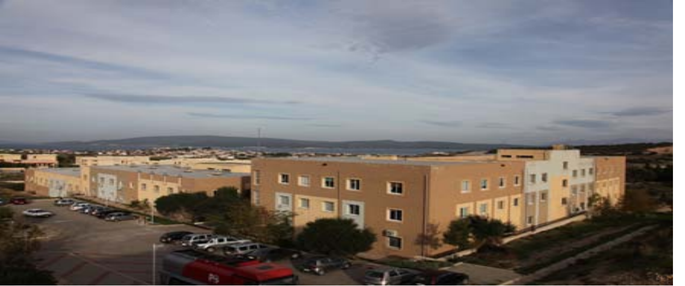
Fen Fakültesi Dekanlık Binası
